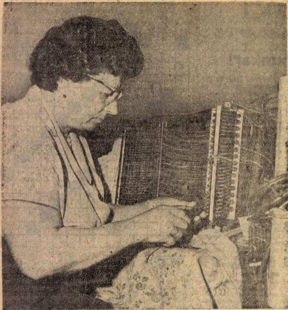
Gyors ütemben építik az új óbudai távbeszélő központot. Császár Józsefné (BHG) a keret feletti forrasúcsán dolgozik
